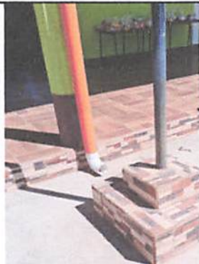
Foto 8: Instalación terminada de bajadas pluviales
