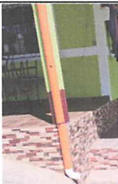
Foto 7: Instalación terminada de bajadas pluviales
