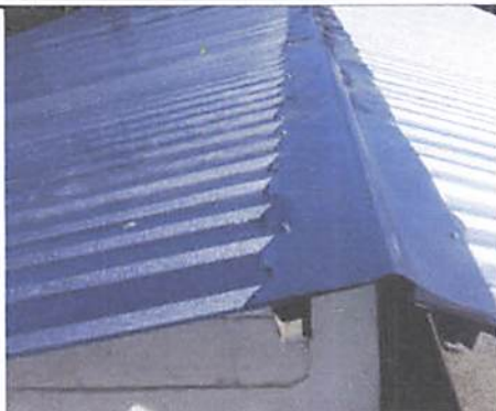
Foto 1: Lámina instalada completamente
