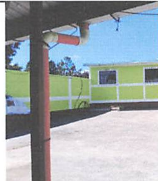
Foto 8: Instalación terminada de bajadas pluviales
