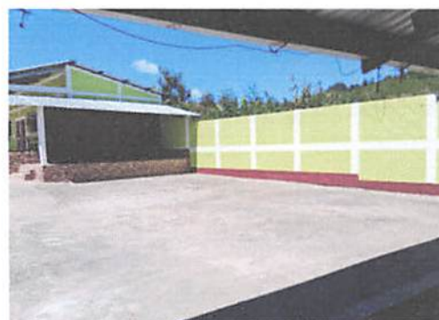
Foto 6: Pintado de la escuela completa finalizado
