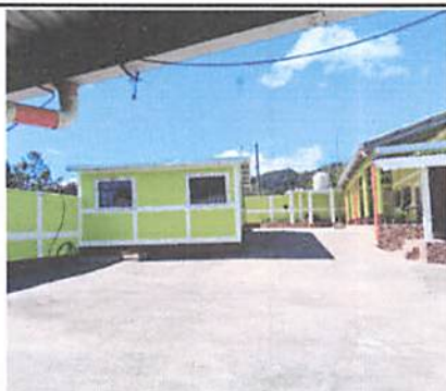
Foto 5: Pintado de la escuela completa finalizado
