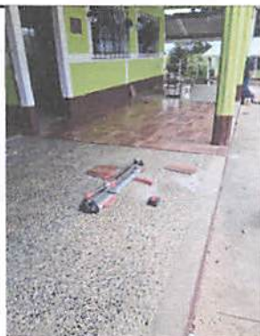
Foto 3: Instalación de piso
