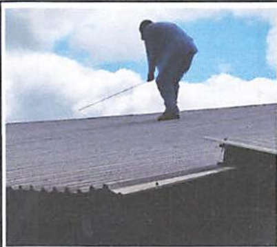
Foto 1: Instalación de lamina nueva
