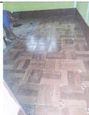
Foto 4: Instalación de piso
