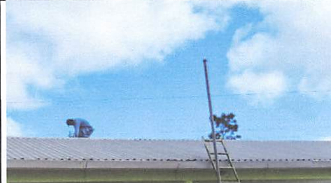
Foto 2: Instalación de lamina nueva
