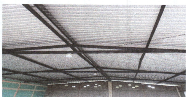
Foto 4: terminación del cambio de techo
