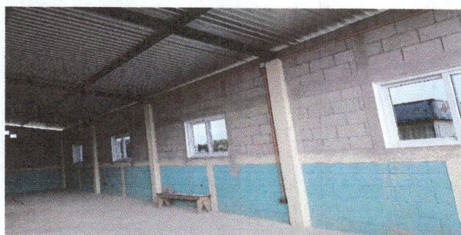
Foto 2: ventanas y levantado de pared
