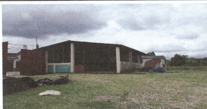
Foto1: Salón en trabajo de remozamiento
