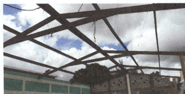
Foto 4: cambio de techado en el salón de usos múltiples
