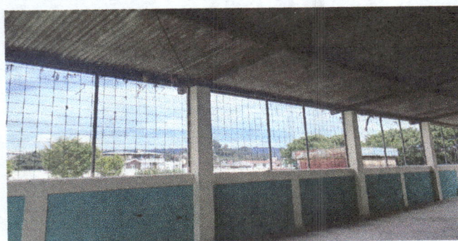
Foto 2: Colocación de ventanas
