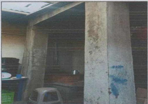
Foto 1: Botar columnas y zapatas
