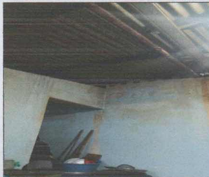
Foto 2: Remover techo y colocar nuevo techado a cocina
