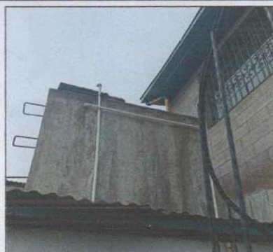
Foto 4: Remover depósito de agua de concreto y colocar depósito plástico de agua
