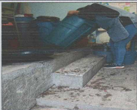
Foto 3: Nivelación de piso en cocina
