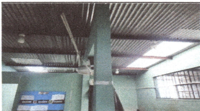
Foto 3: Techo de cocina, instalación de lamiluz.
