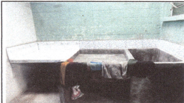
Foto1: Cocina, mejoramiento de pila.
