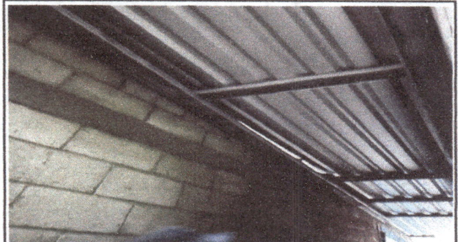
Foto 4: servicio sanitario de maestros, cambio de techo, levantado de pared para habilitación de bodega de gas.
