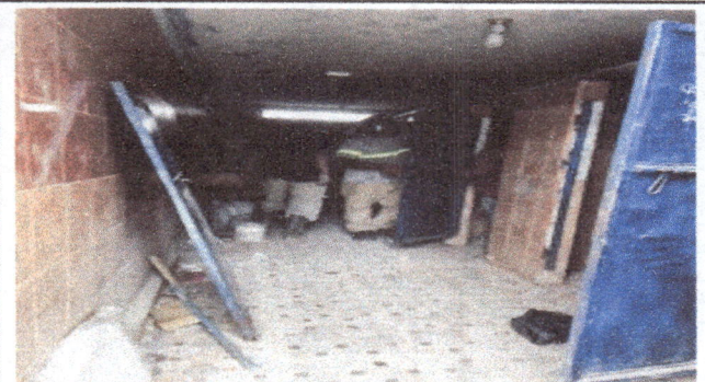
Foto 2: Servicios sanitarios mujeres, remozamiento, piso, puertas, baños y ventilación.
