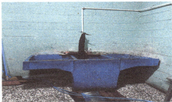
Foto 1: Cocina, mejoramiento de pila.
