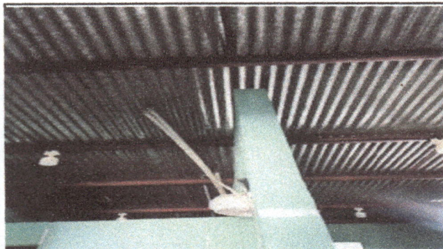
Foto 3: Techo de cocina, instalación de lamiluz.
