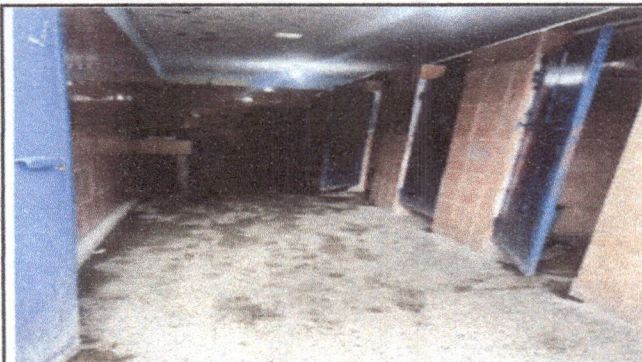
Foto 2: Servicios sanitarios mujeres, remozamiento, piso, puertas, baños y ventilación.
