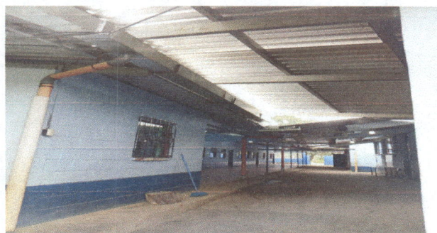
Foto 3: canales y bajadas de agua pluvial
