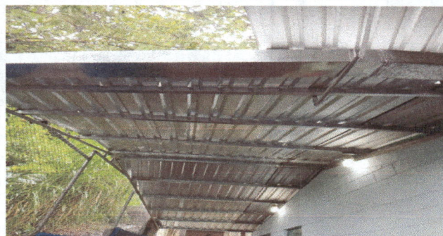
Foto 5: cubierta de láminas y estructura de techo
