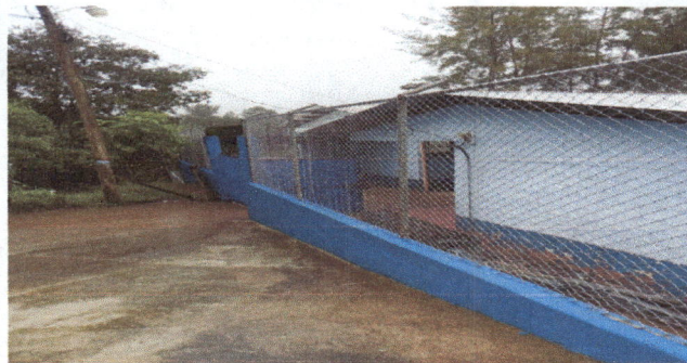
Foto 4: pintura en muros interior y exterior
