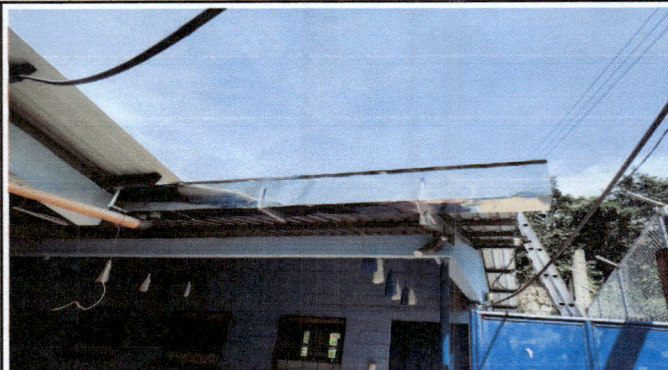
Foto 2: Finalización de canales para techos del establecimiento.
