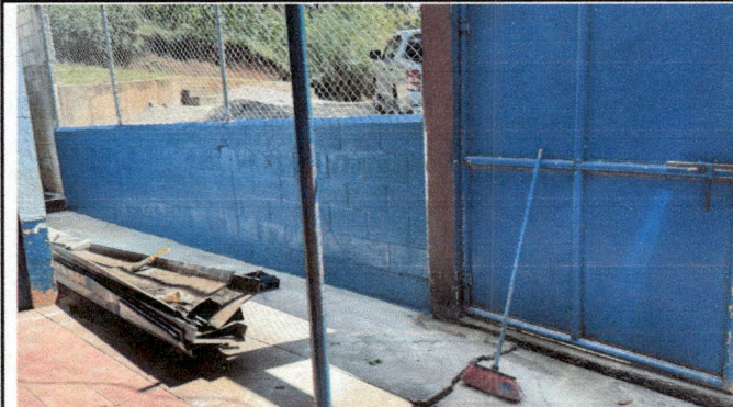
Foto 4: Pintura de muro del establecimiento.
