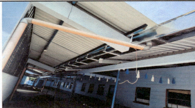
Foto 1: Finalización de canales para techos del establecimiento.
