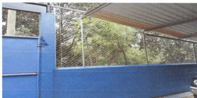
Foto 5: pintura en muros interior y exterior
