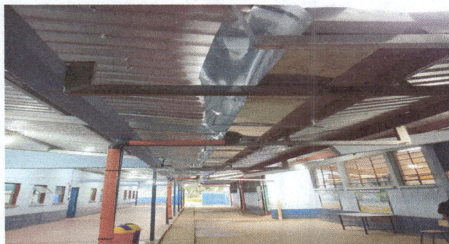
Foto 2: canales y bajadas de agua pluvial
