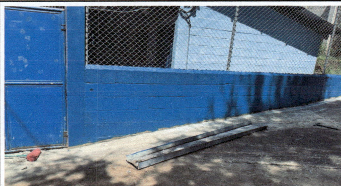
Foto 3: Pintura de muro del establecimiento.
