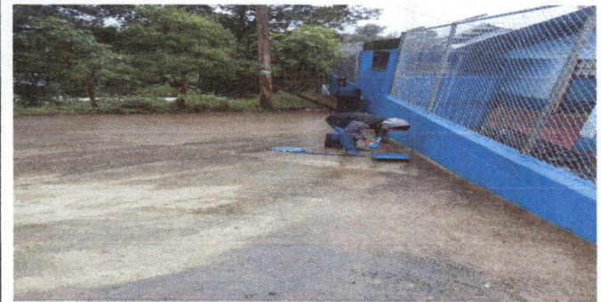
Foto 4: pintura en muros interior y exterior
