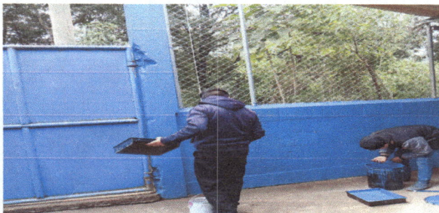
Foto 5: pintura en muros interior y exterior
