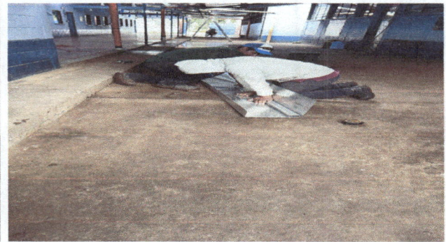
Foto 2: canales y bajadas de agua pluvial
