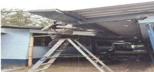
Foto 3: canales y bajadas de agua pluvial
