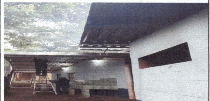
Foto 6: cubierta de laminas y estructura de techo
