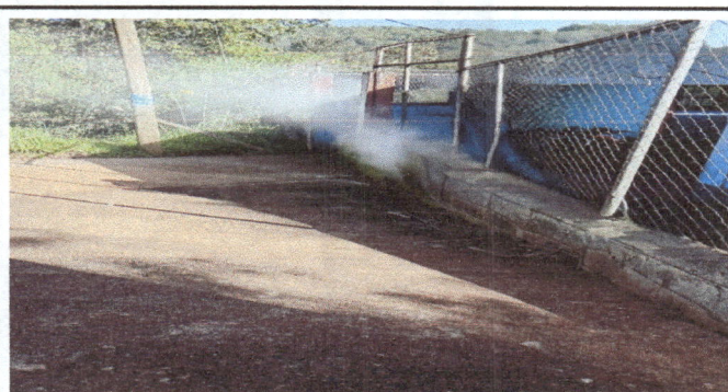
Foto 4: pintura en muros interior y exterior
