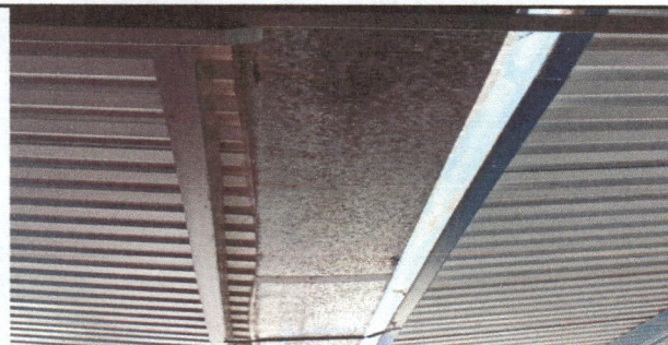
Foto 3: canales y bajadas de agua pluvial
