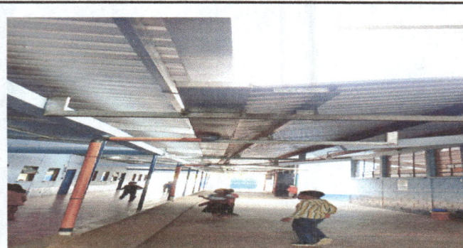
Foto 2: canales y bajadas de agua pluvial
