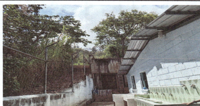
Foto 6: Realización de techo para pila
