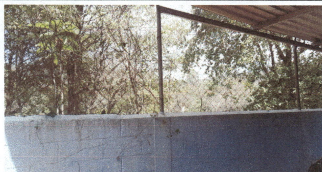
Foto 5: pintura en muros interior y exterior
