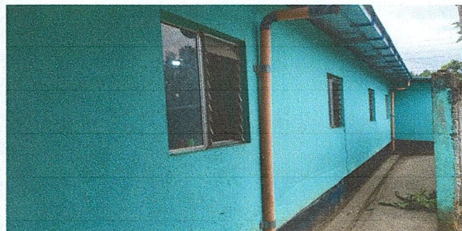
Foto 6: ausencia de balcones
