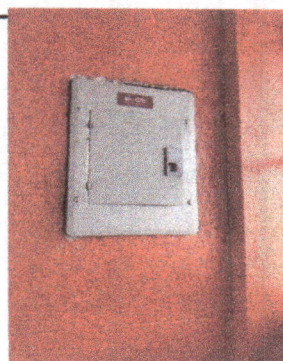
Foto 6: Reparación del sistema eléctrico, sustitución de cajas y flipones.
