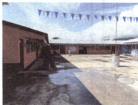
Foto 4: Se aplicará pintura a toda la escuela interior y exterior (9 salones, cocina, escenario, corredores, muro)
