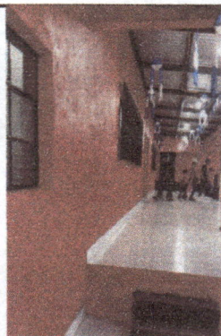
Foto 3: Mantenimiento de balcones, pintura.
