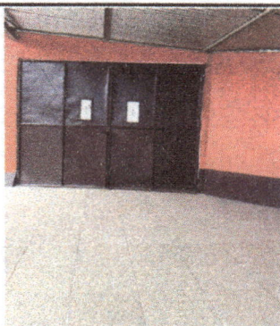
Foto 5: Mantenimiento de portón con pintura.
