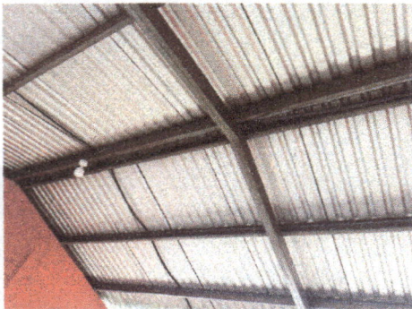
Foto 9: Cableado eléctrico, focos, tomacorrientes para cinco salones, corredores y cocina.
