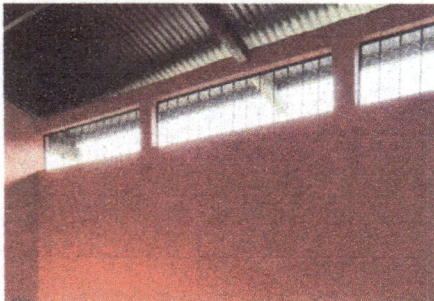
Foto 11: Colocación de tres balcones en la cocina
