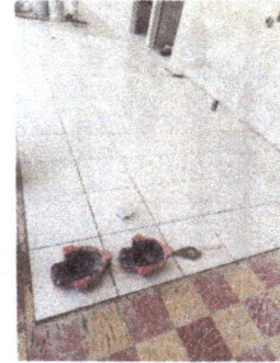
Foto 8: Se observa el piso antiguo el cual sera sustituido por piso ceramico. En total seran 3 salones
