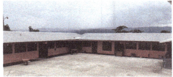
Foto 4: Se aplicará pintura a toda la escuela interior y exterior (9 salones, cocina, escenario, corredores, muro)
