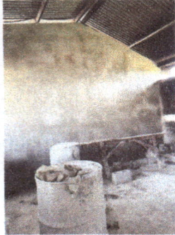
Foto 7: En todas las paredes de la cocina se aplicara repello.
