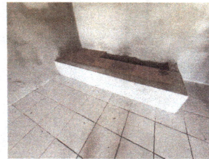
Foto 10: Colocación de piso cerámico en la cocina.
