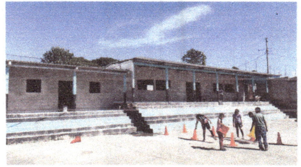
Foto 2: Cambio de repello de tres salones.
