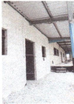
Foto 3: Mantenimiento de balcones, pintura.
