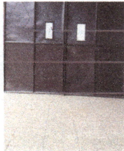
Foto 5: Mantenimiento de portón con pintura.
