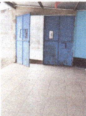
Foto 5: Mantenimiento de portón con pintura.
