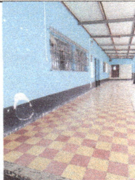
Foto 3: Mantenimiento de balcones, pintura.
