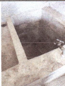
Foto 13: Colocación de azulejo en pila de la cocina
