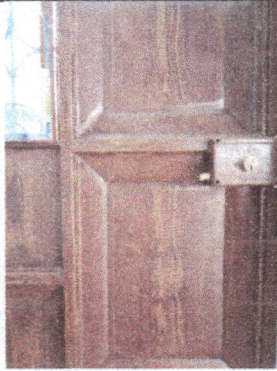
Foto 1: Cambio de chapa, puerta principal
