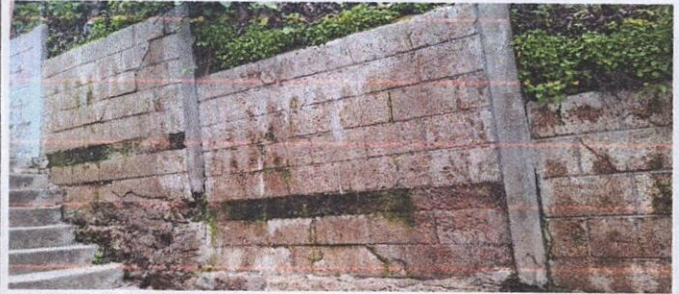
Foto 2: se ubica en un espacio importante ya que conduce a los sanitarios y planta baja de la misma escuela.
