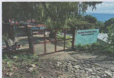
Foto 4: Reparación de drenaje en la entrada principal del establecimiento
