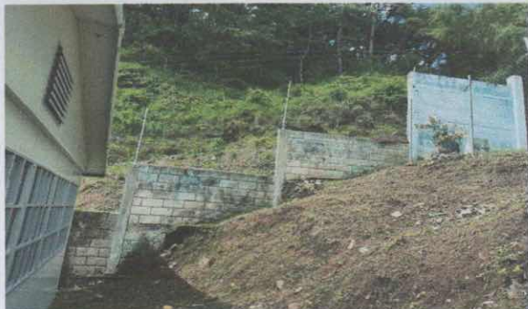
Foto1: Protección de talud por riesgo a deslave y dañar el módulo donde se ubica Preprimaria
