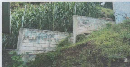
Foto 6: Daños por las correntadas de agua, por lo que requiere proteger el talud y reparación de drenajes
