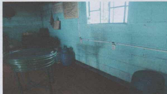
Foto 2: Reparación en el área de cocina para mejorar la ubicación de los instrumentos que se utilizan para cocinar
