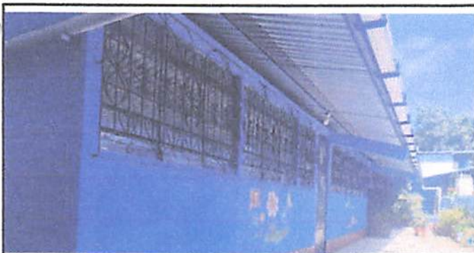
Foto 5: Instalación de balcones con su respectivo acabado
