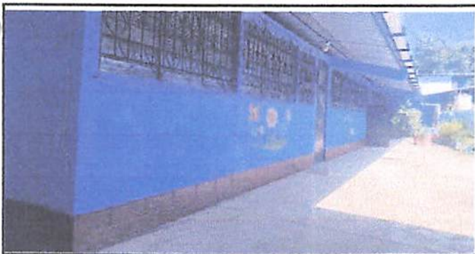
Foto 5: Instalación de balcones con su respectivo acabado
