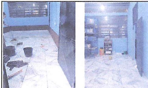
Foto 4: ampliación de área demolida con su cambio de piso
