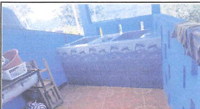
Foto 4: acabado final de pileta con su respectivo azulejo
