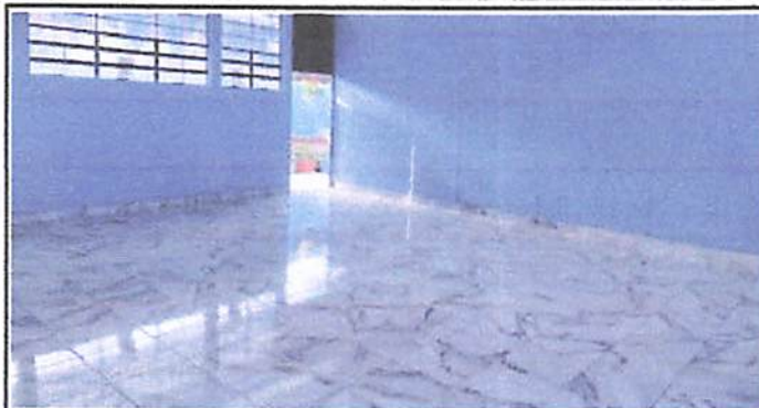
Foto1: cambio de piso en aula
