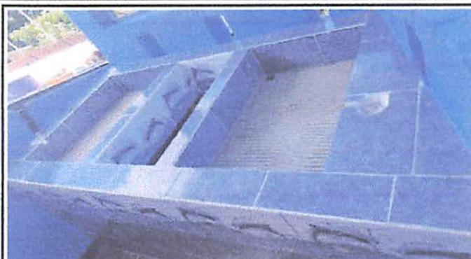
Foto 2: instalación de azulejo a pileta de cocina
