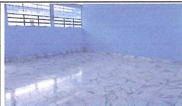
Foto 2: Instalación de zócalo en muros y pintura en paredes
