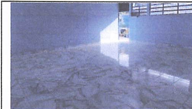
Foto 3: cambio de piso y pintura en muros aula 2
