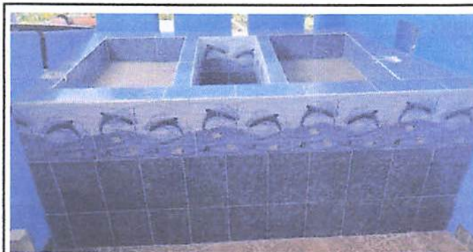
Foto 3: aplicación de estuque en azulejeado de pileta
