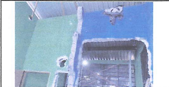
Foto 5: Muros a demolidos para ampliación de espacio
