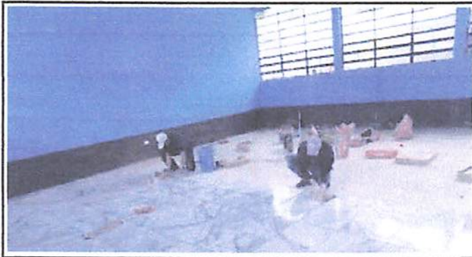
Foto 3: nivelación para instalación de piso en aula de cuarto primaria
