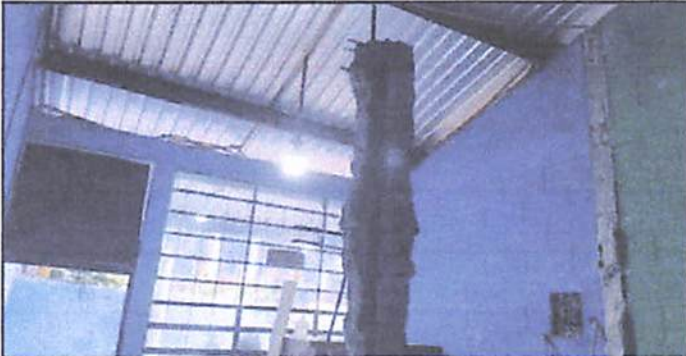
Foto 6: avance de demolición en muros para ampliación
