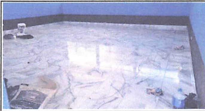
Foto 4: aplicación de estuche para piso en aulas.
