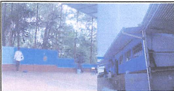
Foto 5: aplicación de pintura en muros
