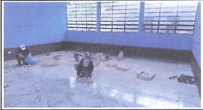
Foto 2: pegado e instalación de piso en aulas
