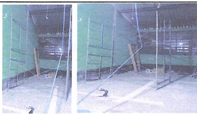
Foto 4: despeje de áreas para colocación de piso.
