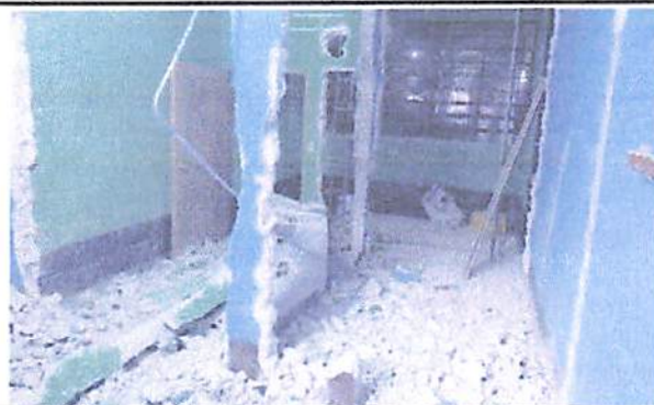
Foto 2: demolición y extracción de ripio.
