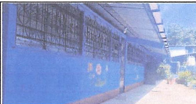
Foto 6: aplicación de pintura en diferentes áreas de la escuela
