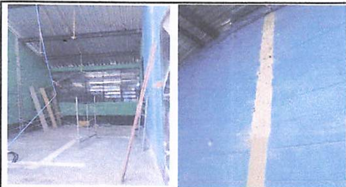
Foto 3: limpieza de área demolida.
