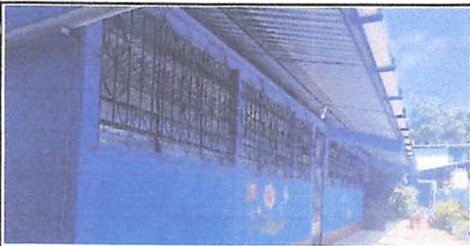
Foto 5: balconeado de aulas
