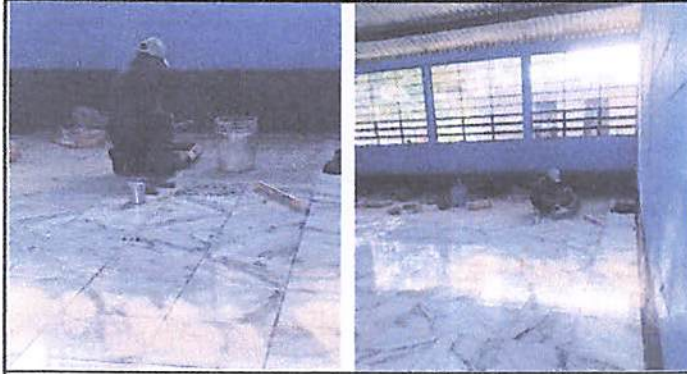
Foto1: cambio de piso en aulas
