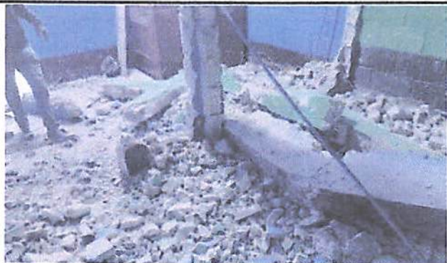
Foto1: Demolición total de muros existentes.
