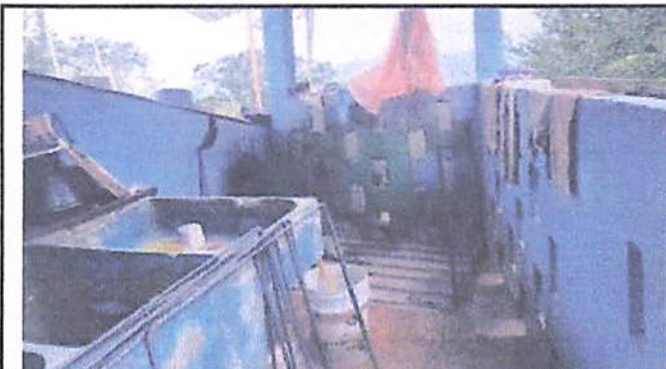
Foto 2: reparación de pileta
