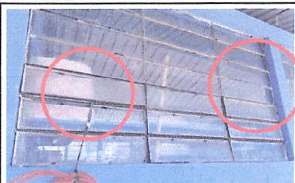
Foto 2: Instalación de balcones en ventanas de aulas
