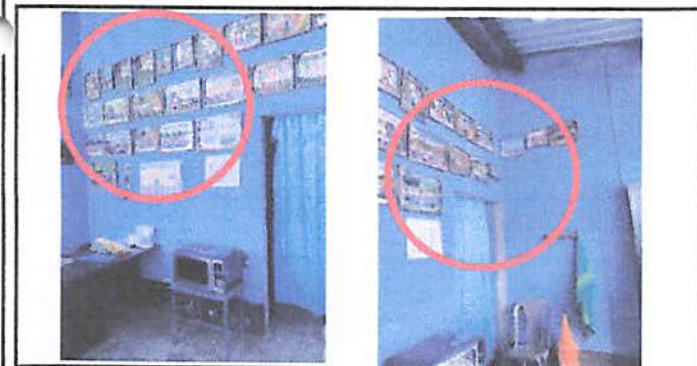
Foto 5: Muros a demoler en ampliación de espacio
