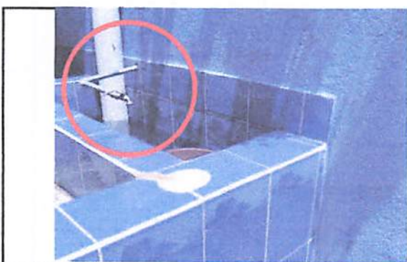
Foto 5: cambio de tubería para reparación de pila
