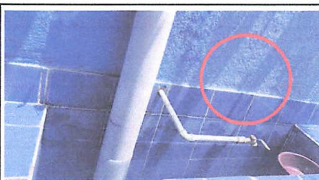
Foto 4: reparación de pila de cemento y azulejo
