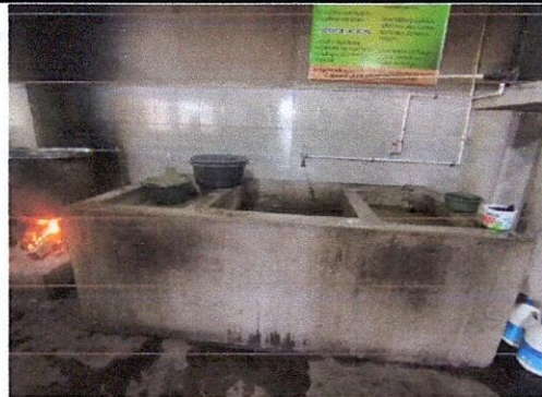
Foto 2: Colocación de azulejo en pila
