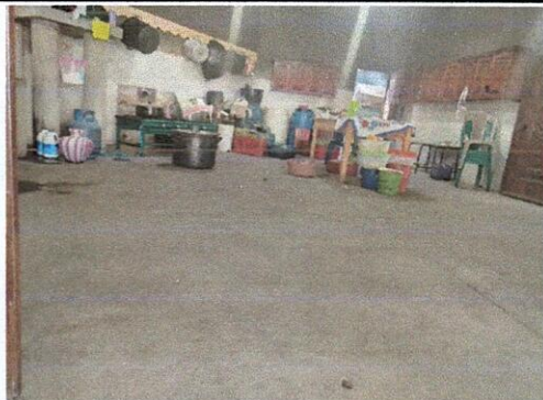
Foto1: Colocacion de piso cerámico
