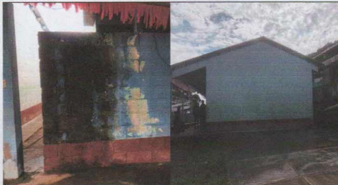
PINTURA EN MURO INTERIOR Y EXTERIOR
