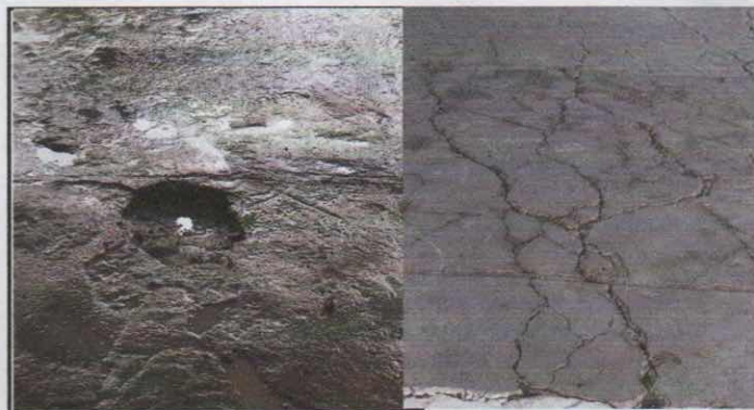
LOSA DE PATIO
