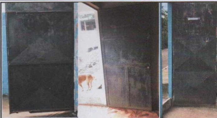
REPARACIÓN DE PUERTAS
