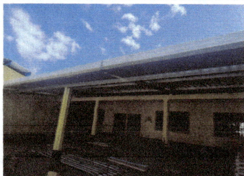
Foto 3: Reparacion de estructura metálica y cambio de techo en patio de ingreso
