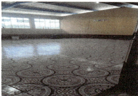
Foto 5: Cambio de piso modulo 1
