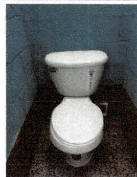
Foto 4: Reparacion de sanitarios y pintura interior
