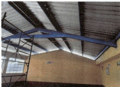
Foto1: Reparación de estructura y cambio de lámina en aula
