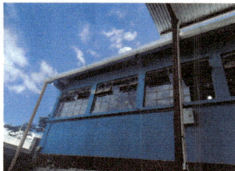
Foto 2: Cambio de canales
