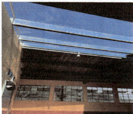
Foto 1: Modulo 3 cambio de techo y pintura en estructura metálica
