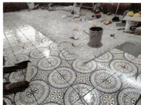
Foto 4: modulo 1 Y 2 cambio de piso
