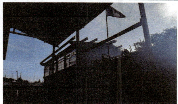
Foto 2: Modulo 3 cambio de techo y pintura en estructura metálica y cambio de canales
