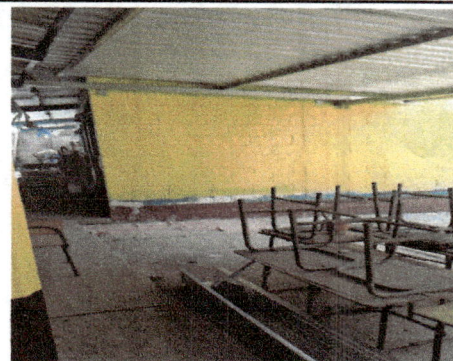
Foto 4: Modulo 1,2 y 3 pintura de paredes exteriores
