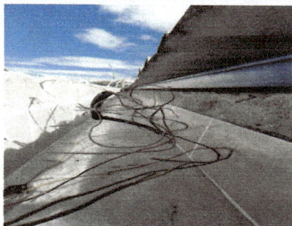
Foto 5: Modulo 3 limpieza de canaleta y ahislamiento de cables de electricidad
