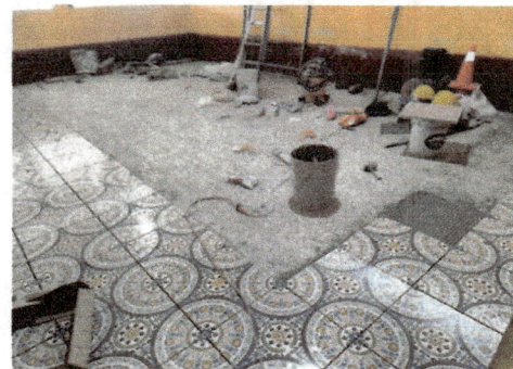
Foto 6: cambio de piso enn modulo 1, 2 y 3
