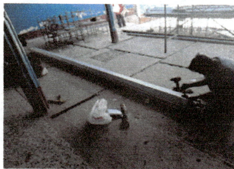
Foto 5: cambio de techo patio de ingreso
