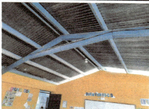
Foto1: Modulo 3 cambio de techo y pintura en estructura metálica
