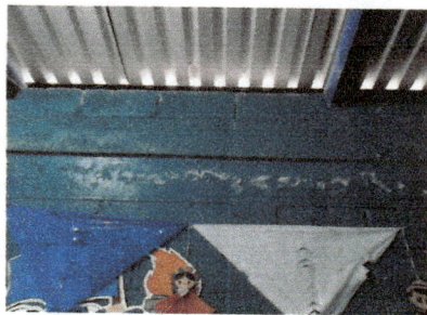
Foto 5: Pintura en paredes exteriores
