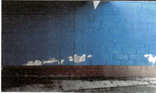
Foto 1: pintura en paredes exteriores
