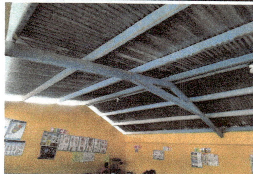
Foto 2: Modulo 3 cambio de techo y pintura en estructura metálica
