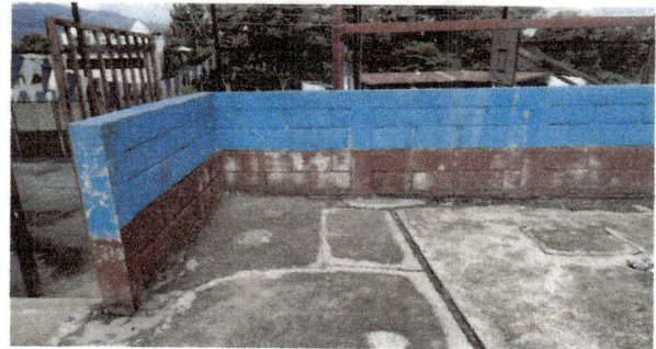
Foto 6: Pintura en paredes exteriores
