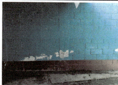
Foto 6: cambio de techo de patio de ingreso y pintura de paredes
