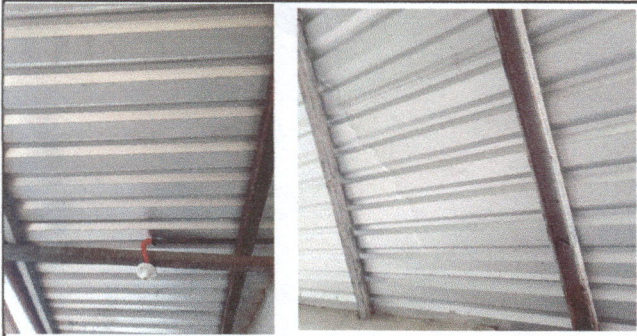
Foto 5: finalización de sustitucion de lámina por lámina troquelada.
