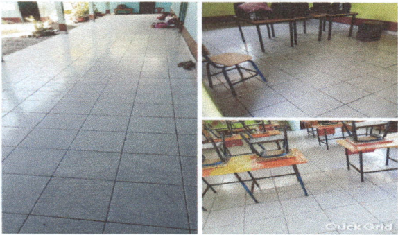
Foto1: finalizacion de inatcción de piso ceramico en salones y corredor del establecimiento.
