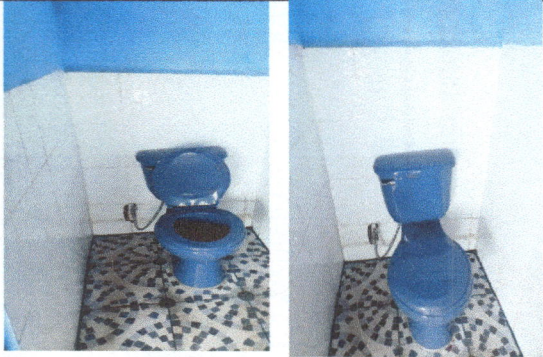
Foto 2: cambio de dos servicios sanitarios.
