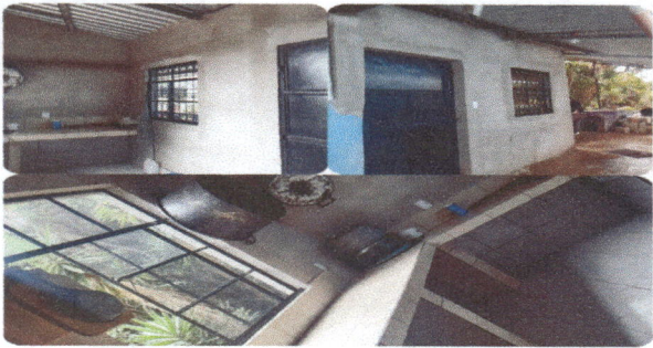
Foto 3: finalizacion de ampliacion de cocina e implementacion de gabinete en forma de L e instalcion de ventanas y balcon para mejorar la iluminación.
