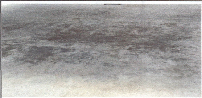
Foto 4: finalización de plancha de patio
