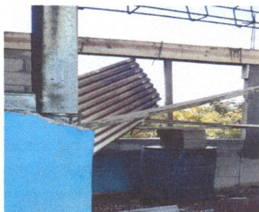
Foto 5: avance de sustitución de lámina
