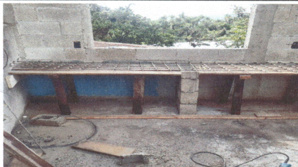
Foto 3: avances de ampliacion de cocina de 1.5 metros cuadrados e implementacion de gabinete en forma de L.
