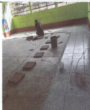
Foto 1: avance de instalacion de piso ceramico en salones.
