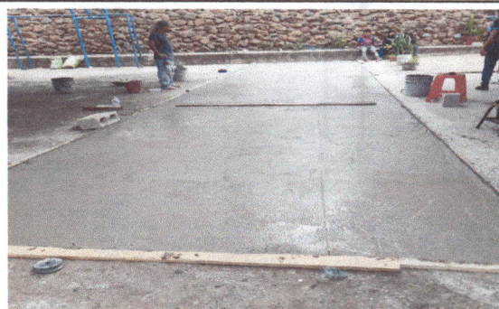
Foto 4: avances de reparacion de plancha de concreto de patio.
