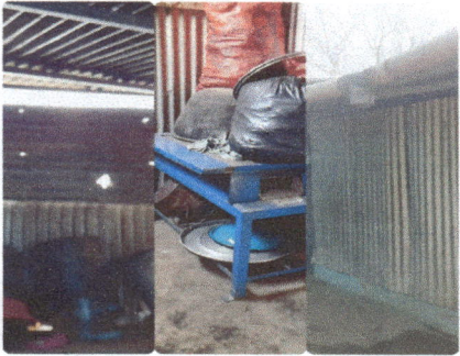
Foto 3: ampliacion de cocina de 15 metros cuadrados, implementacion de un gabinete de concreto tipo L para guardar los utensilios de cocina, ventanas amplias para mejorar la iluminacion de la cocina.
