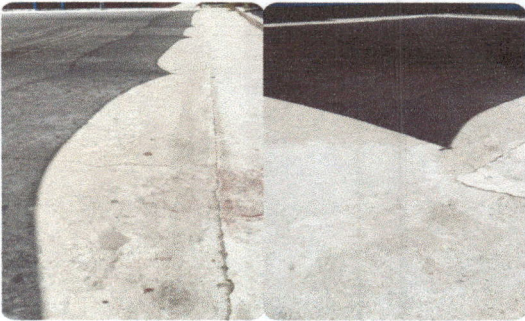
Foto 4: reparación de planchas de concreto de patio.
