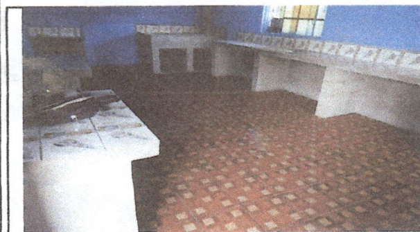
Foto 3: remodelacion de cocina.
