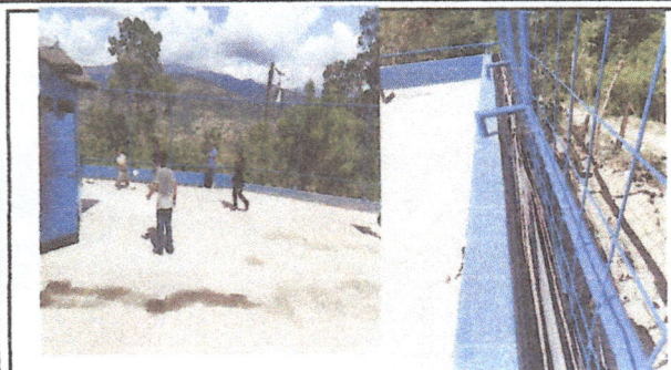
Foto 1: mejoramiento de losa de patio.
