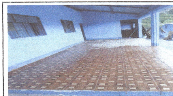
Foto 4: cambio de piso.
