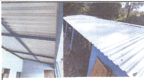
Foto 2: cambio de techo y costaneras.
