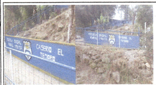
Foto 5: muro de contención.
