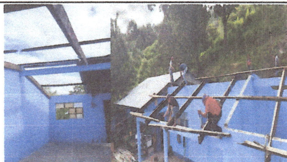
Foto 2: cambio de techo y constaneras
