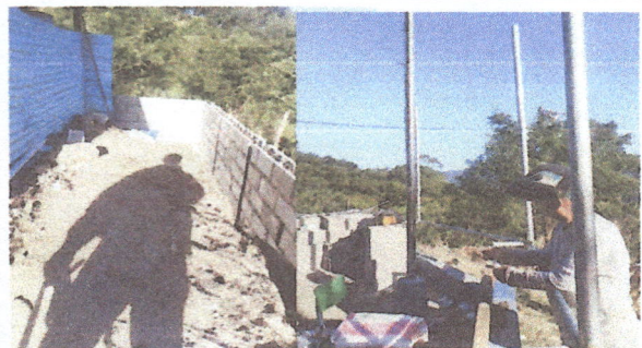
Foto 1: mejoramiento de losa de patio.
