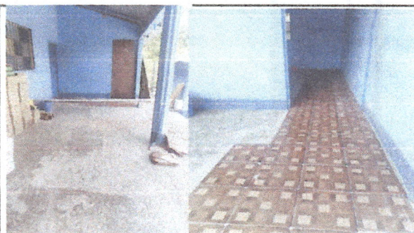
Foto 4: cambio de piso.
