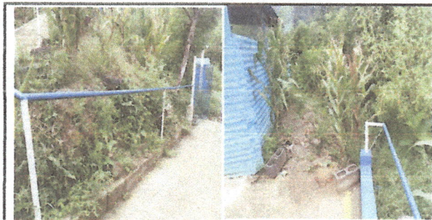
Foto 5: muro de contension
