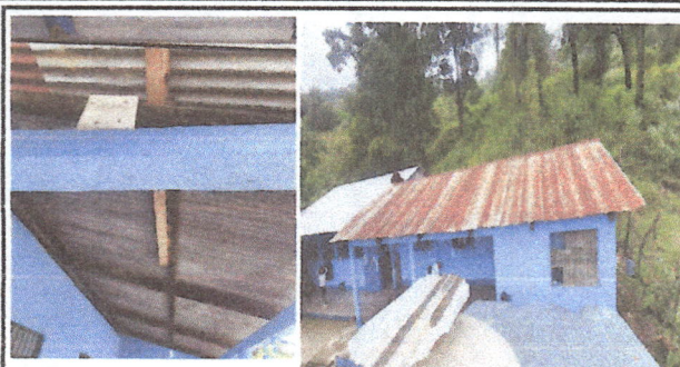
Foto 2: cambio de techo y constaneras.
