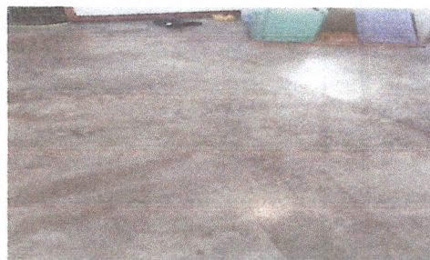
Foto 4: cambio de piso.
