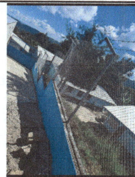
Foto 6: Colocación de maya en muro perimetral y pintura.
