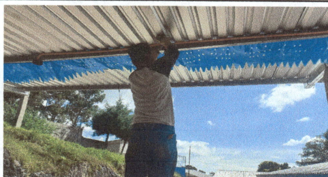
Foto 5: Colocación de sistema electrico en el escenario.
