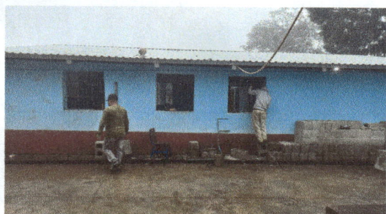
Foto 3: Colocación de Ventanas y Balcones de salón 1, salón 2 y dirección.
