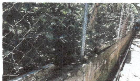
Foto 6: Reparación de muro perimetral cambio de malla y pintura.
