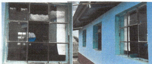
Foto 3: Ventanas y balcones de salón 1, 2 y dirección.
