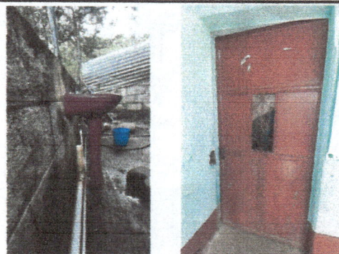
Foto 4: Accesorios de lavamanos, reparación de puerta y puerta nueva.
