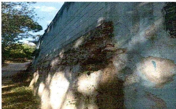
Foto 1: Se necesita reparar tubería de drenaje de pileta.
