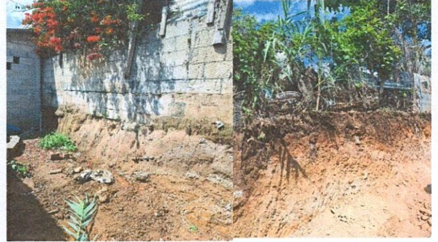
Foto 2: Recubrimiento de talud de muro existente, con un muro de contención
