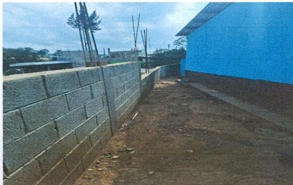
Foto 3: Colocación de malla perimetral para seguridad de los alumnos.
