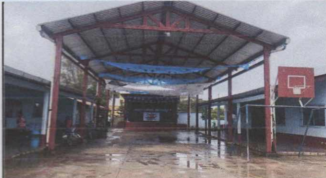
Foto 8: Mantenimiento de pintura columnas y Vigas del techado de usos múltiples
