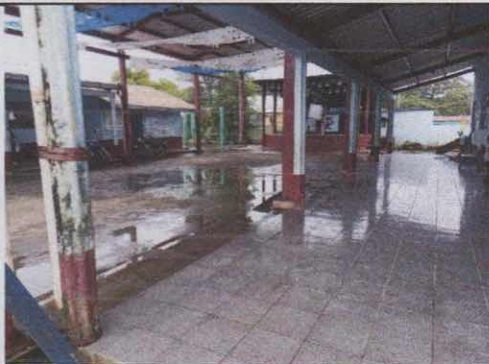
Foto 15: Reparación de 4 columnas de corredor del frente salon parvulos y primero de concreto
