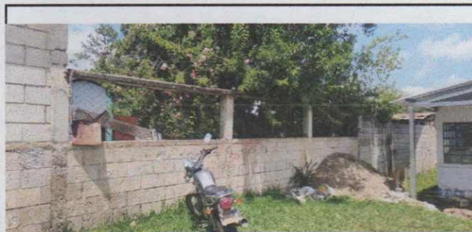
Foto 11: Levantado de Muro Perimetral (se realizará por seguridad del alumnado por peligro de delincuentes)
