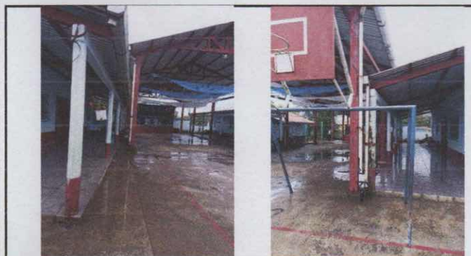
Foto 9: colocación de 10 bajadas de agua de techo que están en mal estado.
