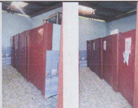
Foto 17: Levantado de pared de los baños (las paredes están demasiado bajas y los niños tienden a espiarse entre ellos)
