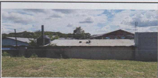
Foto 5: Cerco de malla entre escuela y campo de futbol
