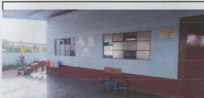
Foto 7: Balcones del salón de primero
