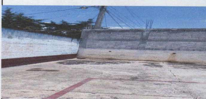
Foto 4: creación puerta y rampa que comunica al campo de futbol para que los niños no salgan a la calle principal
