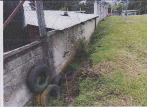
Foto 14: zanqueo de 20 metros para reparación de drenaje de la cocina
