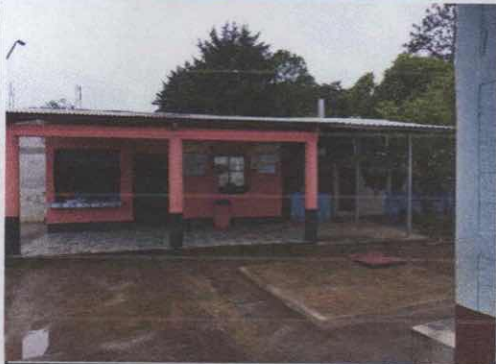
Foto 1: Canal para el frente de la cocina
