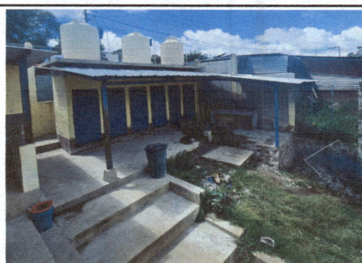
Foto 4: Construcción de muro para lavamanos
