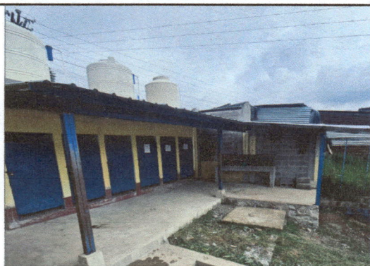
Foto 3: Construcción de muro para lavamanos
