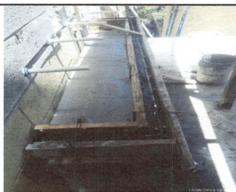
Foto 4: Construcción de muro para lavamanos
