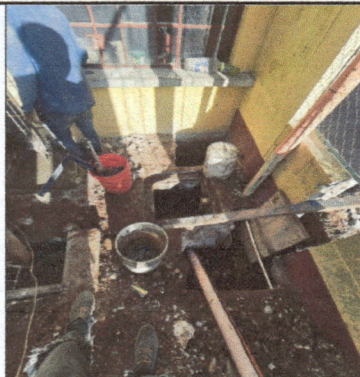
Foto 1: Construcción base para tinaco para uso de cocina
