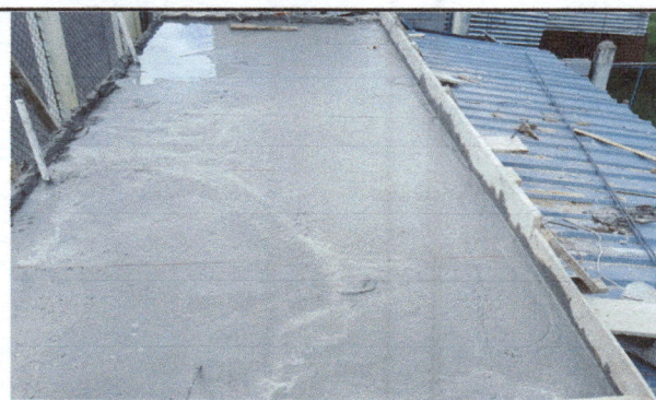
Foto 6: Construcción de loza para dos tinacos
