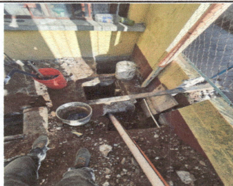
Foto 2: Construcción base para tinaco para uso de cocina
