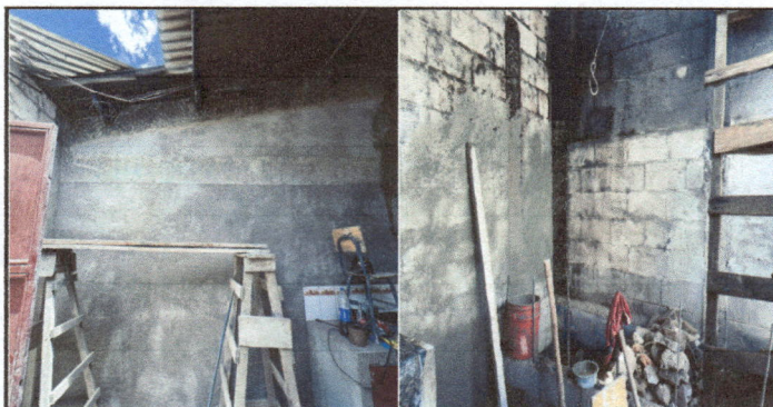
Foto 5: Mano de obra para remodelación de cocina
