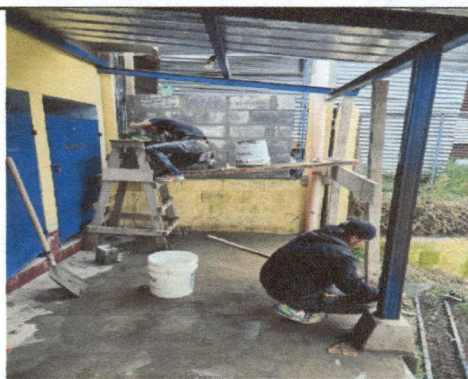
Foto 3: Construcción de muro para lavamanos
