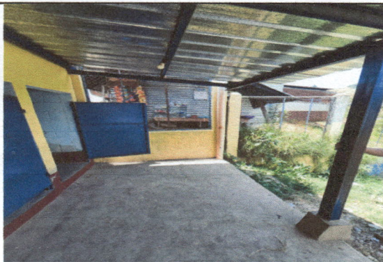
Foto 3: Construcción de muro para lavamanos
