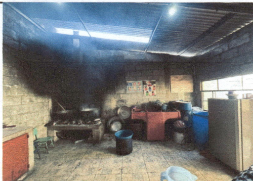
Foto 5: Mano de obra para remodelación de cocina
