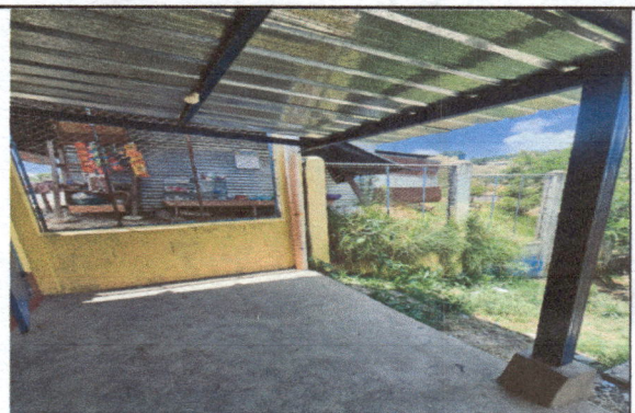
Foto 4: Construcción de muro para lavamanos
