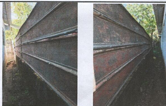
Foto 6: area atrás de dos salones y cocina, no cuenta con muro, está cubierto con lámina, se necesita contrapiso.
