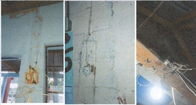
Foto7: Reparación Sistema eléctrico
