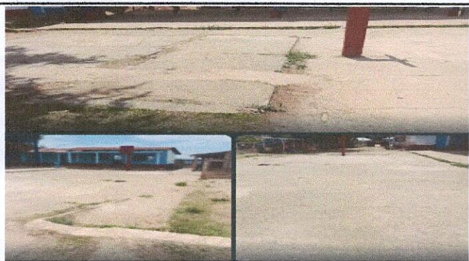
Foto 3: Losa de patio
