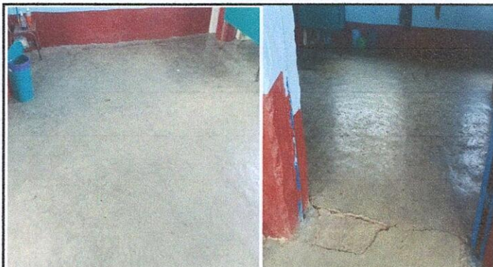
Foto 4: Sustitución de piso de concreto a ceramica
