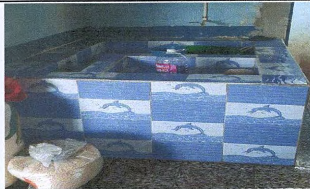
Foto 8: Sustitucion de pila por lava trastos. Dicha accion se realizará debido a que en la actualidad no se le está dando uso debido a que no se ha logrado controlar la fuga del agua.
