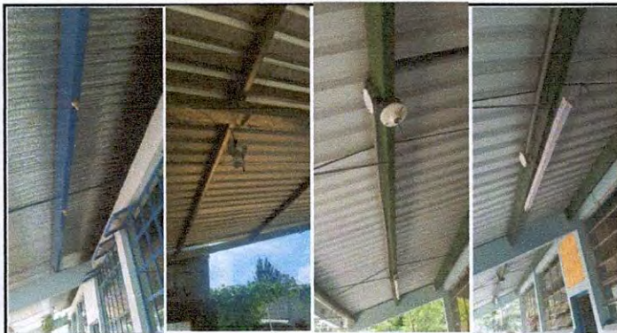
Foto1: Reparacion e instalación del sistema electrico.
