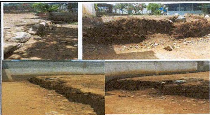
Foto 2: Recubrimiento de talud a través de muro de contención.
