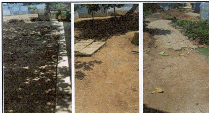
Foto 3: Terminación y colocación de adoquines en área de patio
