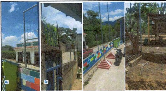
Foto 4: Sustitucion de malla por electromalla
