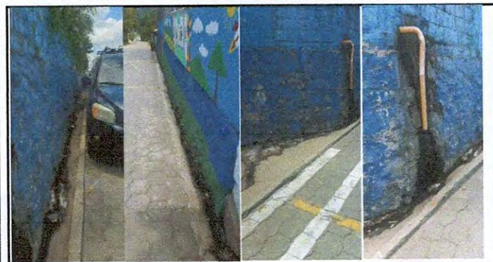
Foto 5: Reparacion y construcción de drenaje de de agua pluvial y recidual
