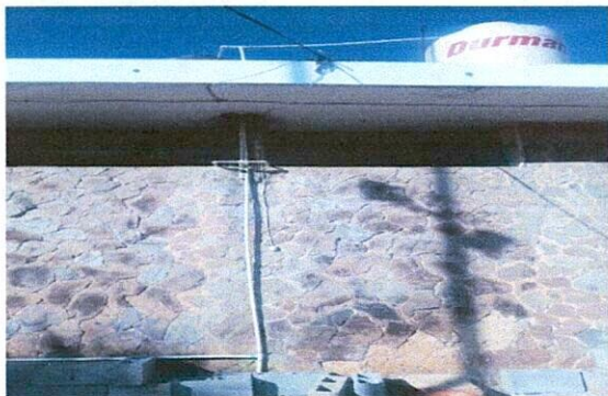
Reparación red de agua.
