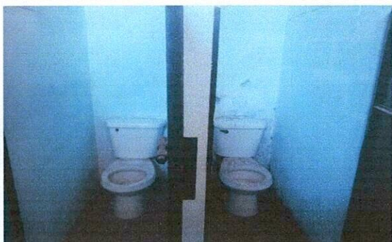
Reparación de sanitarios.
