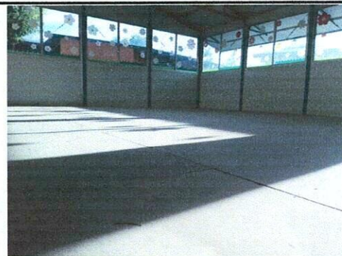
Sustitución de piso de aula de párvulos
