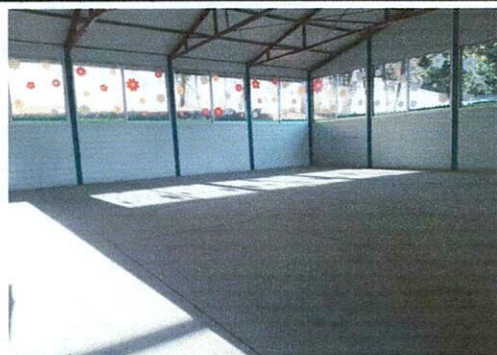
Sustitución de piso de aula de párvulos.
