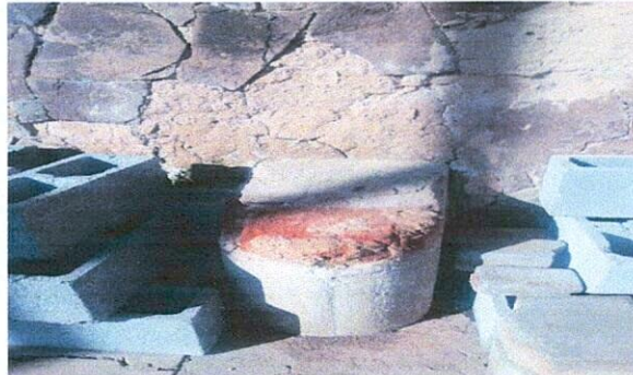
Reparación de drenaje.
