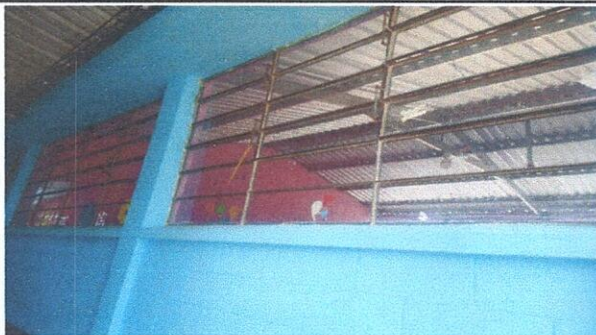
Foto 1: Colocar balcones en aulas de clase, cocina y dirección.
