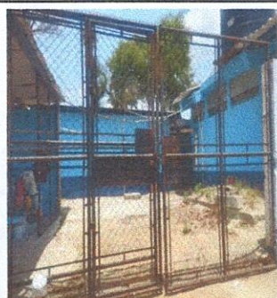
Foto 2: Cambios de las puertas de la entrada de la escuela por puertas y portones formales.
