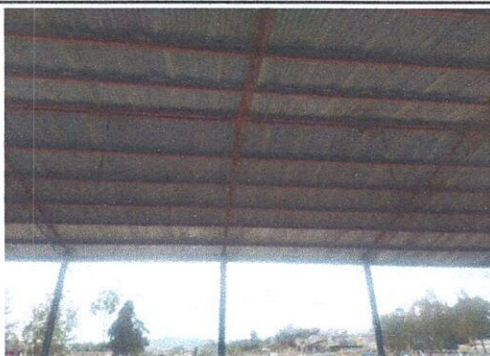
Foto 3: Pintar la lámina del techo de la cancha con pintura anticorrosiva, pintar la estructura metálica. Colocar canales y bajada de agua de uno de los lados del techado de la cancha.
