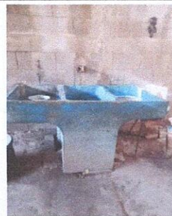
Foto 6: Sustitución de pila de concreto por su deterioro.
