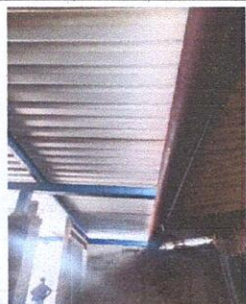
Foto 5: Caída de agua para el mejoramiento, para evitar la humedad en la cocina.
