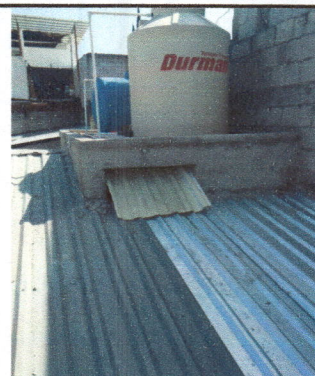
Foto 2: El tinaco presenta fuga debido a su antigüedad. No abastece la red de sanitarios, se escapa el agua por lo que es necesario cambiarlo.
