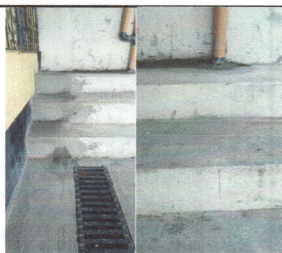
Foto 6: Las tuberías de bajadas de agua hacia el drenaje están sobrepuestas, representa riesgo para los niños, se necesita reubicación para evitar más incidentes.
