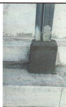
Foto 6: Las tuberías de bajadas de agua hacia el drenaje están sobrepuestas, representa riesgo para los niños, se necesita reubicación para evitar más incidentes.
