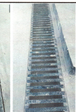
Foto 5: Las cunetas con rejillas instaladas en el patio, se encuentran sobre puestas, los niños se tropiezan al pasar, necesita reparación para evitar más incidentes.
