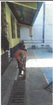
Foto 5: Las cunetas con rejillas instaladas en el patio, se encuentran sobre puestas, los niños se tropiezan al pasar, necesita reparación para evitar más incidentes.
