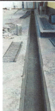
Foto 5: Las cunetas con rejillas instaladas en el patio, se encuentran sobre puestas, los niños se tropiezan al pasar, necesita reparación para evitar más incidentes.
