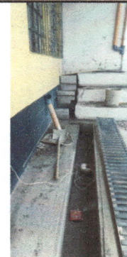
Foto 6: Las tuberías de bajadas de agua hacia el drenaje estan sobrepuestas, representa riesgo para los niños, se necesita reubicación para evitar mas incidentes.
