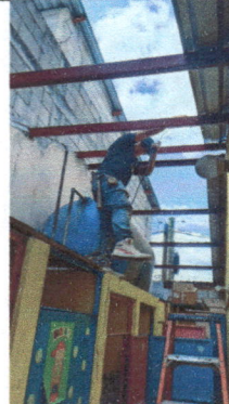
Foto 2: El tinaco presenta fuga debido a su antigüedad. No abastece la red de sanitarios, se escapa el agua por lo que es necesario cambiarlo.
