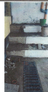
Foto 6: Las tuberías de bajadas de agua hacia el drenaje estan sobrepuestas, representa riesgo para los niños, se necesita reubicación para evitar mas incidentes.
