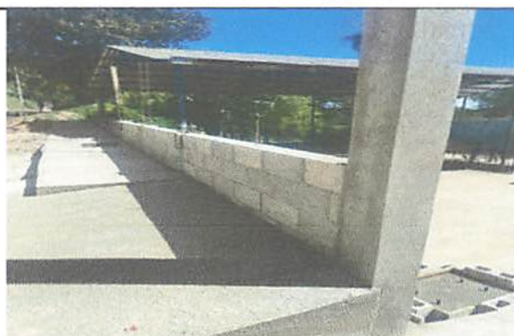
Foto 4: Muro perimetral finalizado.
