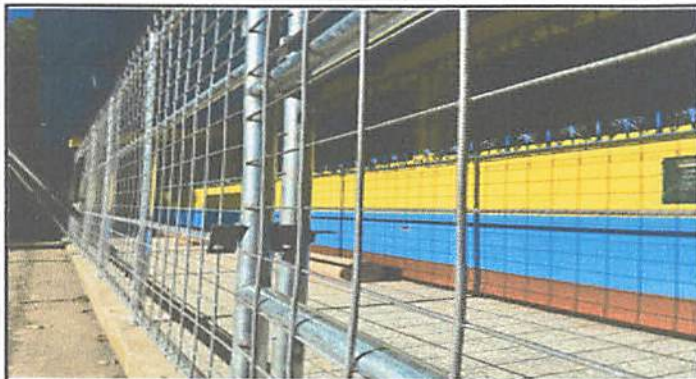
Foto1: Electromalla instalada para proteger los salones de clase
