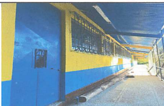
Foto 6: Pintura nueva en la parte exterior de aulas.
