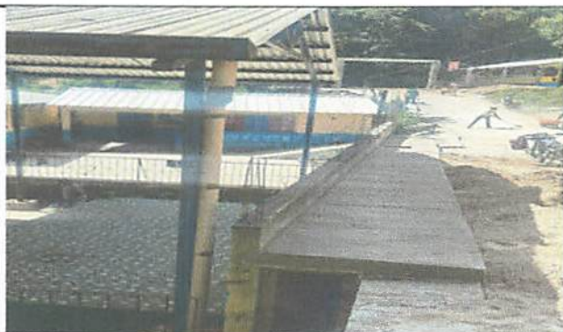
Foto 5: Se cubrió la cuneta de drenaje en la entrada del establecimiento.
