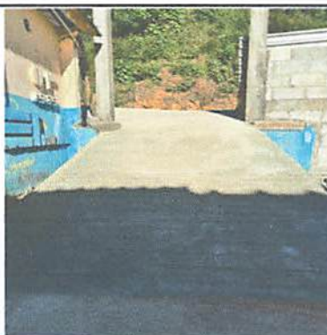
Foto 2: Construida la rampa de entrada que beneficiará a la comunidad educativa.
