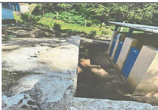
Foto 3: Construido el muro de contención frente a los sanitarios.
